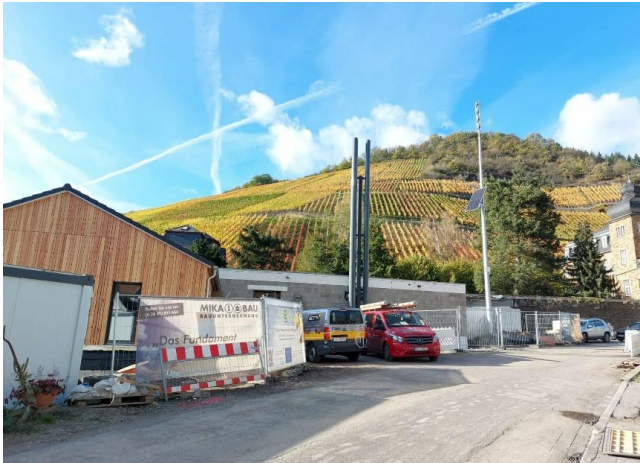
Baustelle der Heizzentrale in Marienthal (Foto: eegon)
