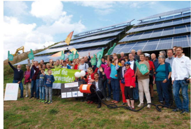
Eröffnung der PV-Freiflächenanlage Kirchartd (2015) © EnerGeno Heilbronn-Franken eG
